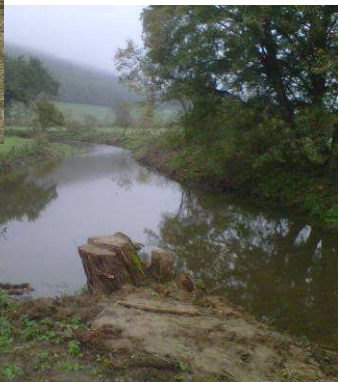
Amont de la zone de connexion : bras fortement encombré. Extraction de la végétation et talutage des berges pour faciliter l'apport de lumière et l'installation de végétation de type herbacée.
