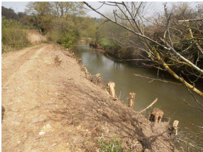
Réalisation de deux peignes afin de limiter l'érosion de la berge (et du chemin) pour maintenir l'accès à une pâture enclavée entre la rivière et le canal des Ardennes
