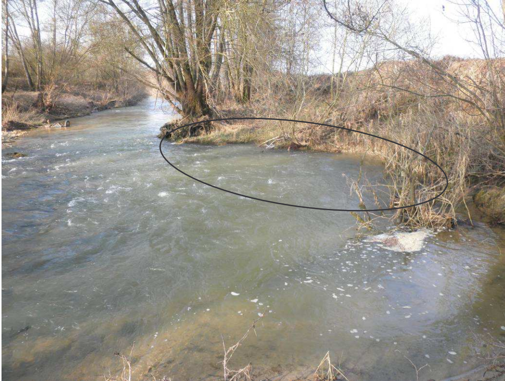
Observation d'une zone d'érosion (encoche).
