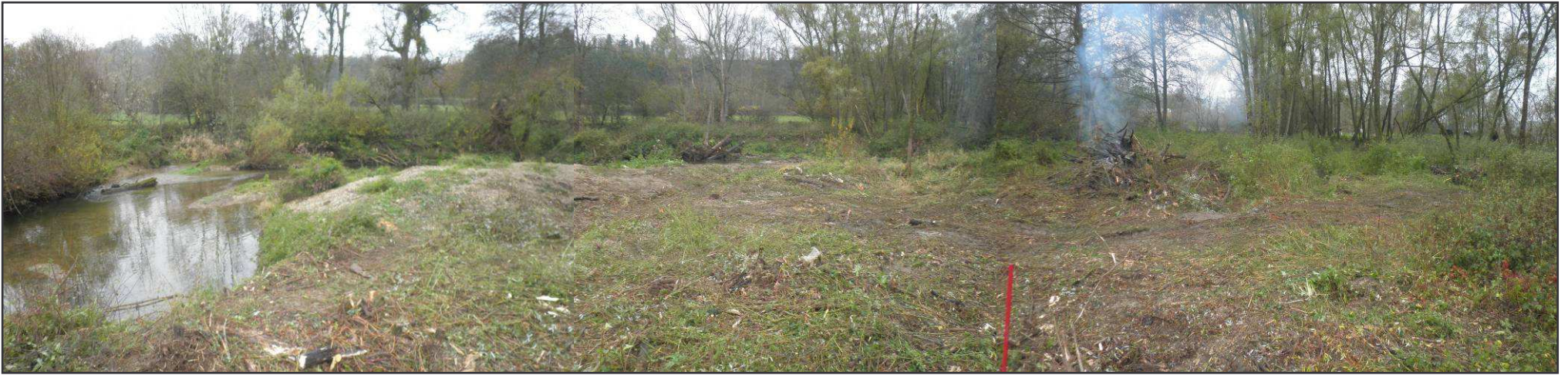
Vue panoramique du dégagement d'un atterrissement par coupe et élimination de la végétation buissonnante (saules)
