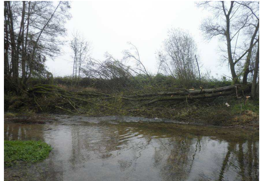
Réalisation d'un « peigne » avec des aulnes et frênes stabilisés par un saule dont la connexion avec la souche a été conservée ceci afin piéger les sédiments et permettre à longs termes la stabilisation de la berge par développement végétal de saules.
