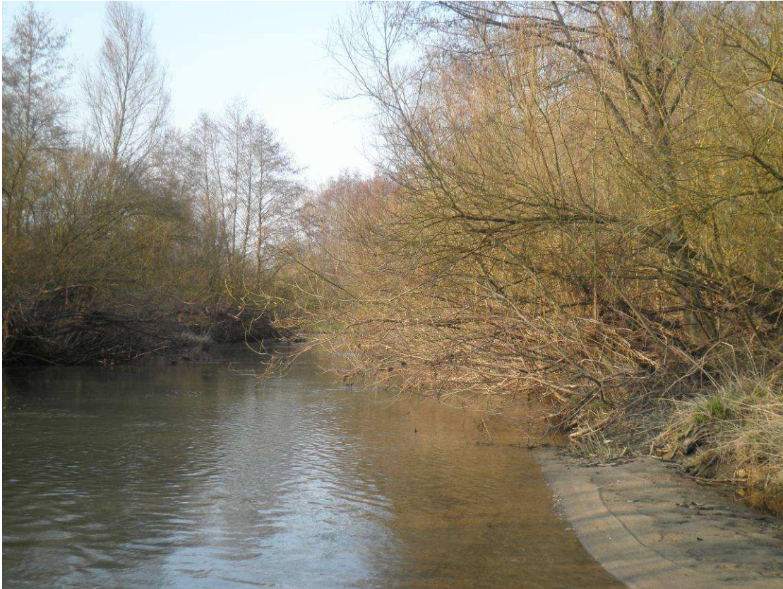
Développement important de végétation buissonnante sur un atterrissement recouvrant fortement le lit de la rivière.
